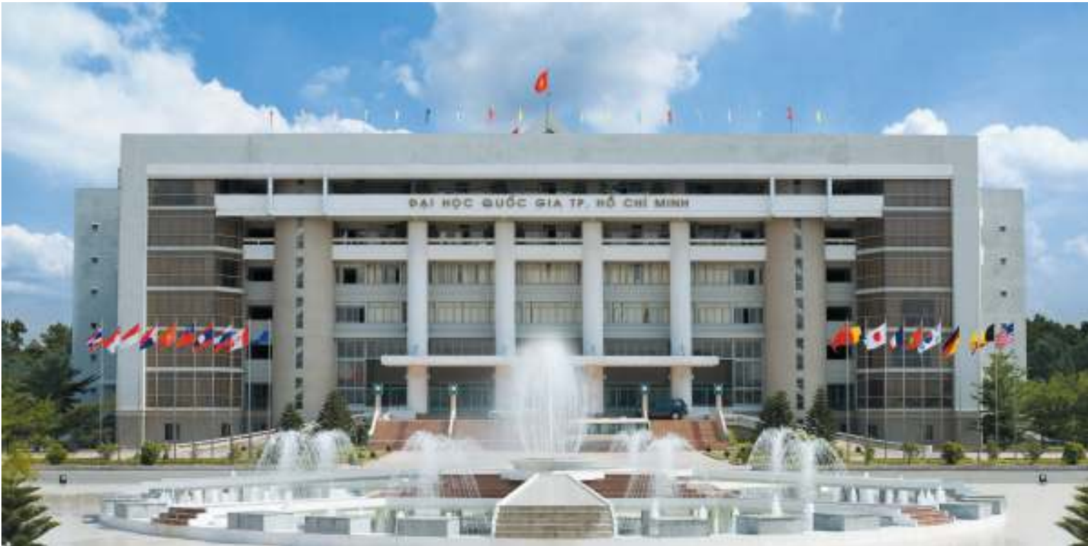
Tòa nhà điều hành mang một phong cách riêng của ĐHQG-HCM.
